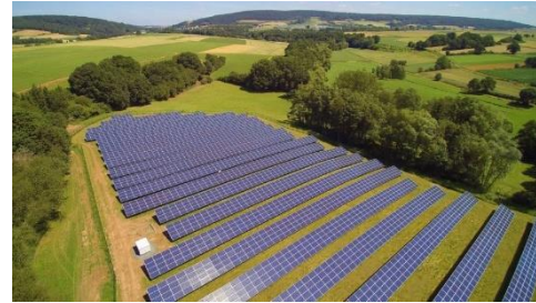
Freiflächen PV Anlage Marberg
